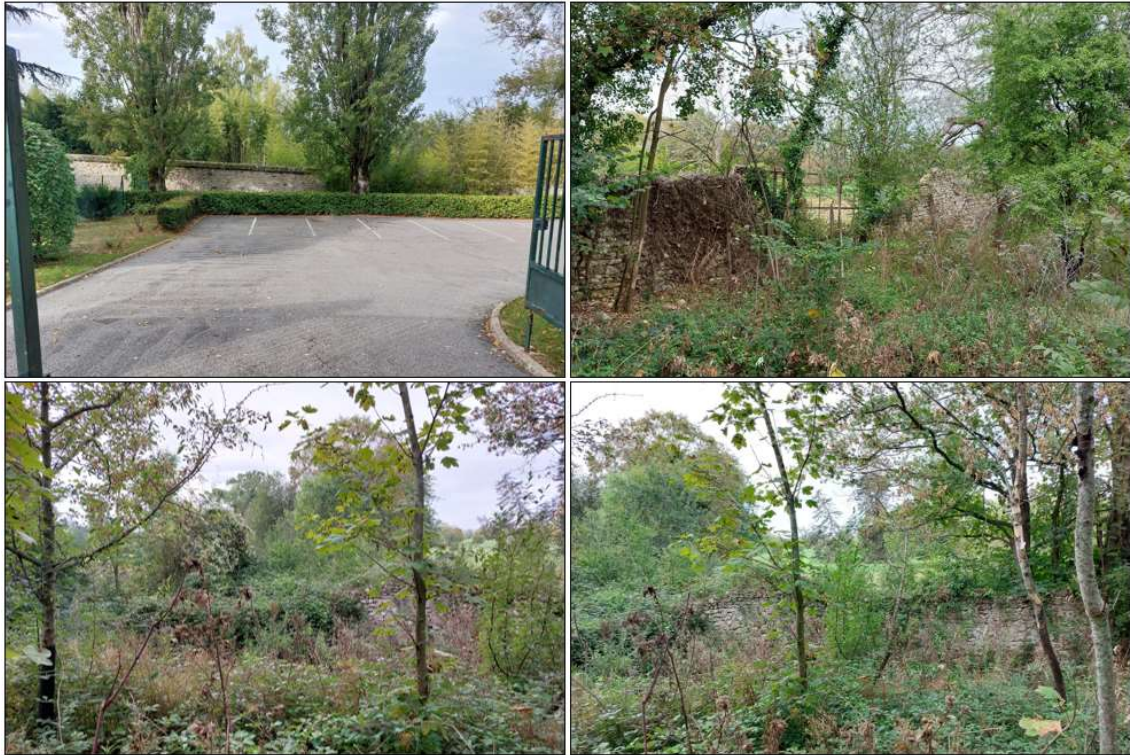
Figure 13 – Photos du mur d’enceinte de l’Arboretum de Chèvreloup au niveau du site des serres et des terrains de tennis
